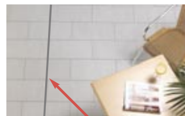
Junta de dilatación
