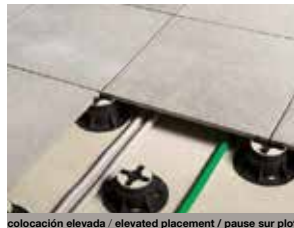
colocación elevada / elevated placement / pause sur plot
